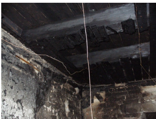
Obr. 9 Stropná konštrukcia nad 1. NP v jedálni po požiarnej skúške. Fig. 9 Floor construction above 1st floor in the dining room of the house after the fire test.
