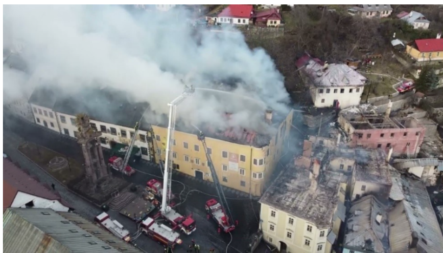
Obr. 1 Požiar v meste Banská Štiavnica ( www.bystricak.sk )
