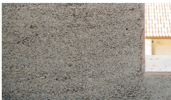
Obr. 1 Stena postavená z konopného betónu Fig. 2 A wall built from hempcrete
